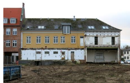
Den nordvendte facade af den bevarelsesværdige bygning.
